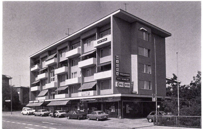
Abbildung 3: Mit ALCAN-Fassade saniertes Wohn- und Geschäftshaus.
