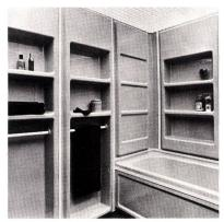
Les modules sanitaires se composent d'éléments préfabriqués pour parois, plafonds et appareils. Baignoires, tubs de douche, lavabos sont en verre acrylique moulé, qualité «S spécial». Les éléments de parois sont réalisés en ABS revêtu de verre acrylique.
