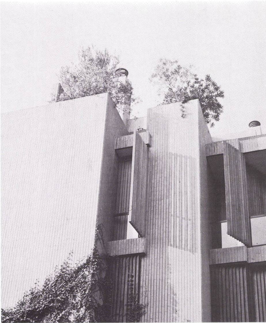
1-5 Zweispännerblocks mit den für Coderch charakteristischen Sonnenschutzgittern an der Calle Raset 21-31 und Calle Freixa 22-32 (1973). Blocs à deux travées avec grilles brise-soleil caractéristiques de Coderch, situés Calle Raset 21-31 et Calle Freixa 22-32 (1973). Two-span blocks with sunbreaks typical of Coderch, situated on Calle Raset 21-31 and Calle Freixa 22-32 (1975).
