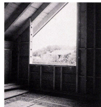
Holzträger mit Heraklit-Leichtbauplatten ausgeführt.
