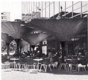
**Flächentragwerke** sind eine Spezialität von Schenker. Flächentragwerke sind textile, mobile oder starre Bauformen mit gestalteter und gestaltender Funktion. Schenker hat eine breite Palette verschiedener Grundtypen:
