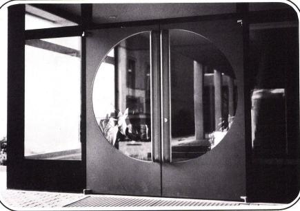
Eingangspartie in Leichtmetall-Konstruktion
