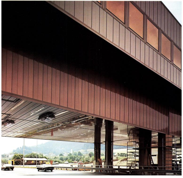
Ein Archiv Grosse, fensterlose Fassadenflächen in einer anspruchsvoll geplanten Neubauzone. Gelöst mit der LUXALON® Aluminium-Fassade Typ 150 F. Das ausgefeilte System von Tragerippe und Paneel entspricht den bauphysikalischen Forderungen. Das ist Voraussetzung. Der gestalterischen Freiheit sind durch die breite Farbskala kaum Grenzen gesetzt.
