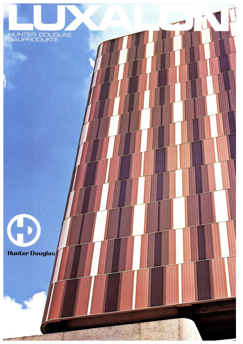
Ein Autobahnrestaurant LUXALON® Aluminium-Fertigwand aus 60 cm breiten, 50 mm dicken Paneelen Typ 605. Ausgezeichnete Wärmedämmung (0,43 kcal/m² h °C) und Lärmisolation. Problemlose Montage. Unsichtbare Befestigung. Die doppelte Einbrennlackierung ist witterungsbeständig und äusserst einfach in der Wartung. Die grosse Auswahl an lichtechten Farben ermöglicht unzählige dekorative Kombinationen.
