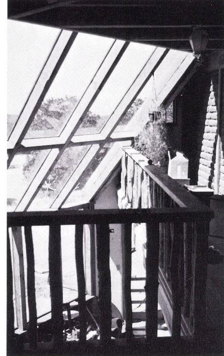
Dieses passive System wird etwa 80% der Raumheizung bei durchschnittlichen Winterbedingungen liefern. Es basiert auf einem 40 m<sup>2</sup> großen, zweistöckigen, nach Süden gerichteten, doppeltverglasten Gewächshaus zum Sammeln der Sonnenenergie.
