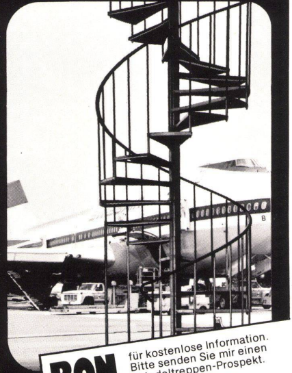
Nottreppe am neuen Fingerdock in Kloten
