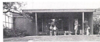
1, 2 Eigenes Haus in Götzis, Vorarlberg (1965/66). Résidence personnelle à Götzis, Vorarlberg (1965/66). Private home at Götzis, Vorarlberg (1965/66).
