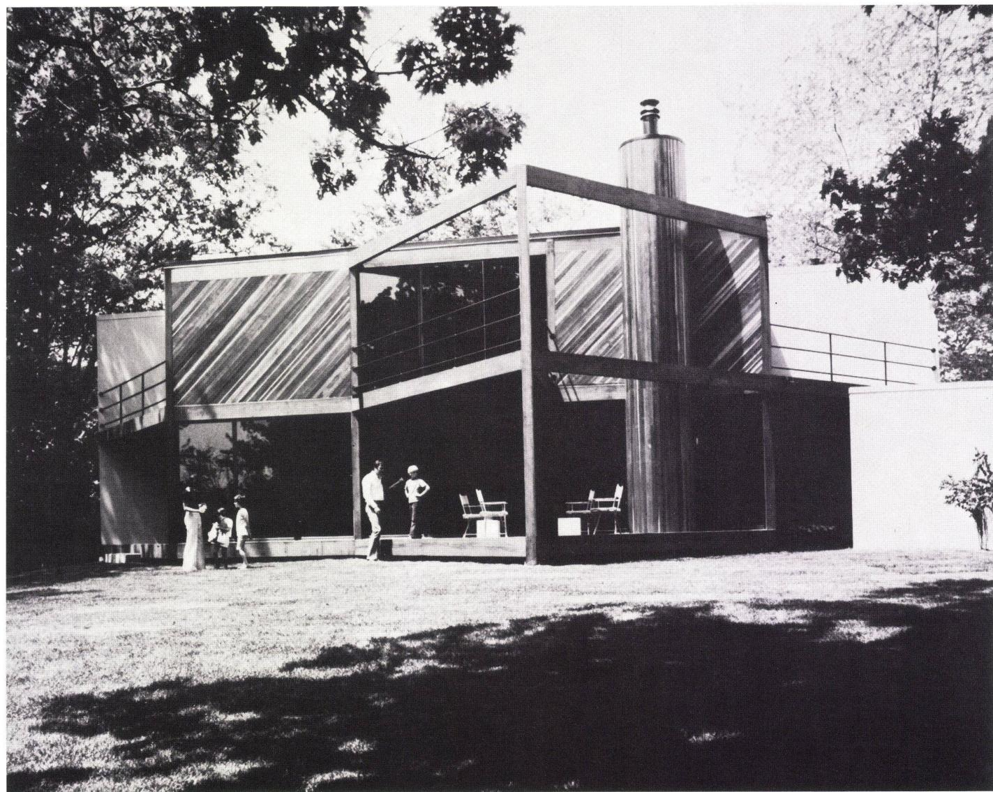
Dieses Experimentierhaus stellt einen Versuch dar, fabrikgefertigte Kernelemente, die alle Naßräume, wie Küche, Bad und WC sowie Heizung und Lüftung enthalten, mit vorgefertigten Holzelementen zu dem Wohn- und Schlafbereich zu verbinden. Die Kernelemente sind  $8 \times 12$  ft. groß, werden von der Fabrik geliefert und wie Trailer zusammengesetzt. Für die Anordnung des Wohn- und Schlafbereiches sind viele Variationen möglich, das Grundmodul beträgt  $12 \times 12$  ft.
