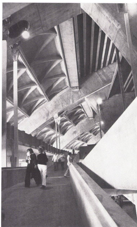
8 Zugangsbereich zu den unteren Sitzen. Links die Rückverankerung der weitausragenden Stadionträger. Zone d'accès aux places inférieures. A gauche point d'ancrage d'une nervure en porte-à-faux portant le stade.
