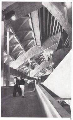
Zugangsbereich zu den unteren Sitzen. Links die Rückverankerung der weitausragenden Stadionträger. Zone d'accès aux places inférieures. A gauche point d'ancrage d'une nervure en porte-à-faux portant le stade.
