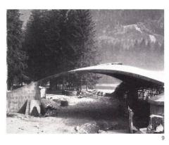
Die statische Berechnung erfolgte zuerst mit Näherungsformeln und anschließend mit Computer-Programmen. Interessant war der Vergleich zwischen errechneten und am Bauwerk gemessenen Biegelinien. Es hat sich erneut bestätigt, daß zu den elastischen Verformungen beim Ausschalen im Laufe der Zeit eine nochmals ein- bis zweimal so große, aber ähnlich verlaufende Durchbiegung hinzukommt.
