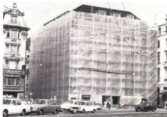
1 Monarflex-Gerüstplane mit Befestigungsösen und Patentbefestigungsglasche für Gerüstmontage.
