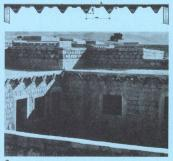
Versuchssiedlung mit hundert Häusern für die Opfer einer Überschwemmung in Berkane, Nordmarokko. Rinnenförmige Flachdachelemente mit Kies für die Drainage und Erde für die thermische Isolation (Schnitt).
