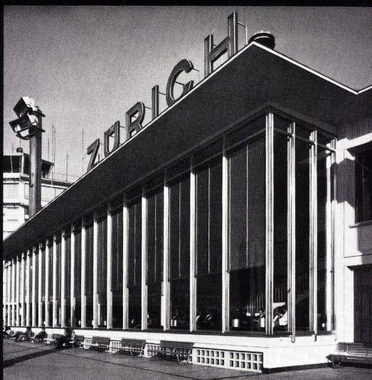
Seit 1951 für den Flughafen Kloten, projektiert, konstruiert, fabriziert, montiert. Aluminium-Fenster- und Fassadenkonstruktionen, Aluminium-Fensterwände und Grossverglasungen, Türen- und Eingangspartien, Staubdecken und Vordächer, Metallarbeiten am Kontrollturm, Aluminium-Pfeilerverkleidungen, diverse Aluminium-Spezialkonstruktionen, Brandschutz-Türabschlüsse, Elektranten-Deckel.
