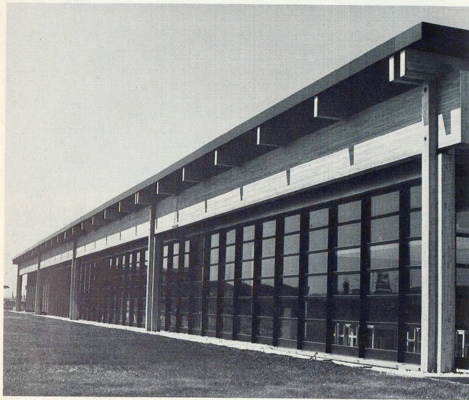
Die Fabrikations- und Lagerflächen sind niveaugleich und nutzungsneutral angeordnet und, soweit baupolizeilich zulässig, ungeteilt in Form eines Großraums, der Austausch, Verkleinerung und Erweiterung der einzelnen Betriebsflächen erlaubt.
