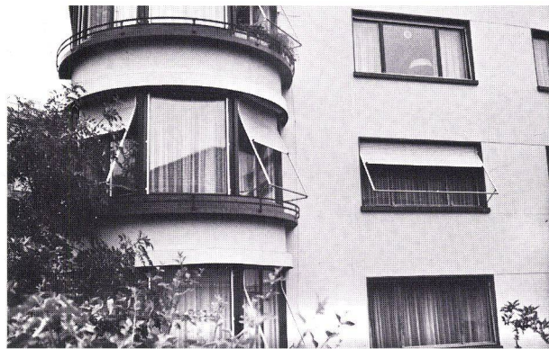
Kt. Bern: Ersatz von Holzrolläden durch ALUMBRA-Rolläden
