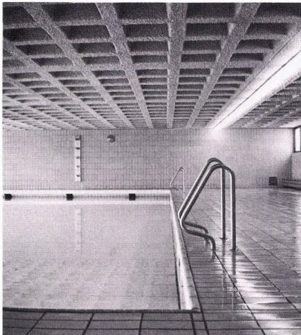
Le plafond alvéolaire de la piscine de l'école de Veyriez (GE) a été réalisé au moyen de caissons PLASTICOFFRE, puis crépi à la «Pierre liquide» pour lui donner un aspect plaisant, tout en diminuant la condensation inhérente aux piscines couvertes.
