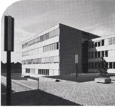
Gymnasium Oberwil BL, Bauzeit 1972/73 Klassentrakt für 590 Schüler. Flexible Grundrisse, Verbindungsbau mit Verwaltungstrakt, Turnhallen. Die nur 16monatige Bauzeit ersparte dem Kanton die Weiterführung teurer Provisorien. Architekten: G. Schwörer + P. Liner, dipl. Architekten, Liestal.
