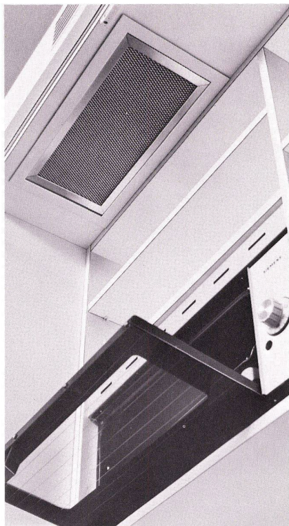
Kleinbackofen mit Ventilationselement für Kochplatten und Backofen
