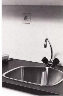
Eingebautes Abwaschbecken mit Mischbatterie und Steckdose für Haushaltgeräte
