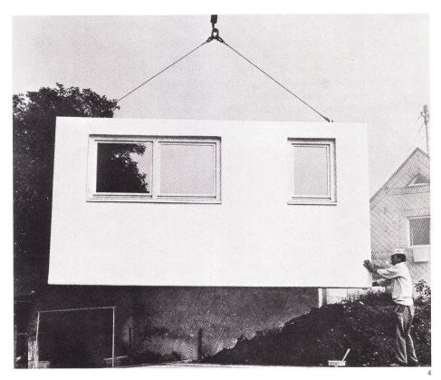
Werbespruch des Herstellers: »Diese Wand mit bereits werkseitig eingebauten Türen und Fenstern sowie einer Vorbeschichtung war ein weiterer Schritt, das Bauen rationeller zu gestalten und die Bauzeit zu verkürzen.« In Wirklichkeit ist die Wand ein Symbol der Unveränderbarkeit, der Rationalisierung auf Kosten des Benutzers. Die Wand läßt sich weder dem Bau anpassen noch läßt sie sich verändern.
