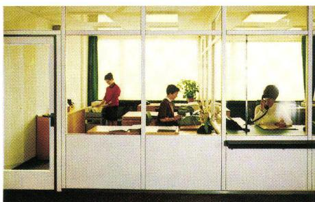
Die mobilen Wände sind aus Spanholz-Vollmaterial, beidseitig mit Kunstharzplatten belegt. Typ A-40: 40 mm stark als Abschlüsse, wenn keine besonderen Anforderungen gestellt werden. Typ C-60: 60 mm stark als vollmobile Bürotrennwand, die normalen
