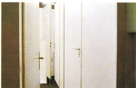
Die WC-Wände sind aus Spanholz-Vollmaterial, Bauhöhe 200 cm, inkl. 10 cm Bodenfreiheit.
