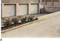
9 Anliker + Co AG, Emmenbrücke Kipptore, halbverschwindend, mit Seilzug. Hubtore mit Gegengewichten und Seilzug Portes basculantes à câbles, partiellement escamotables. Portes coulissantes verticales à câbles et contre-poids
