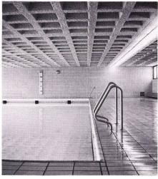
Le plafond alvéolaire de la piscine de l'école de Veyriez (GE) a été réalisé au moyen de caissons PLASTICOFFRE, puis crépi à la «Pierre liquide» pour lui donner un aspect plaisant, tout en diminuant la condensation inhérente aux piscines couvertes.
