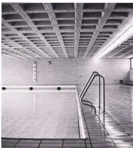
Le plafond alvéolaire de la piscine de l'école de Veyrize (GE) a été réalisé au moyen de caissons PLASTICOFFRE, puis crépi à la «Pierre liquide» pour lui donner un aspect plaisant, tout en diminuant la condensation inhérente aux piscines couvertes.
