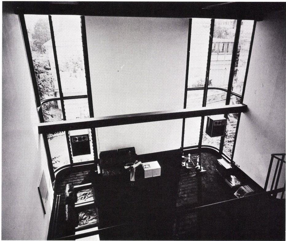
Ce bâtiment à 3 niveaux s'articule en un socle de béton coulé sur place et en une partie supérieure comportant 2 étages exécutée pour l'essentiel en acier et verre. Les pièces d'habitation se répartissent dans ces deux étages. Non seulement les matériaux mais aussi les volumes très dissemblables séparent nettement le sous-basement des étages.
