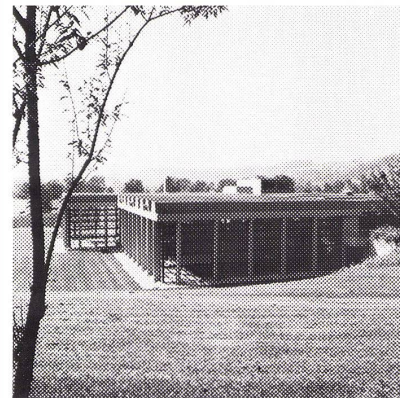
Solche Dachformen, wie z. B. hier beim Hallenbad Baar, können nur mit schrumpffreien Materialien isoliert werden.
