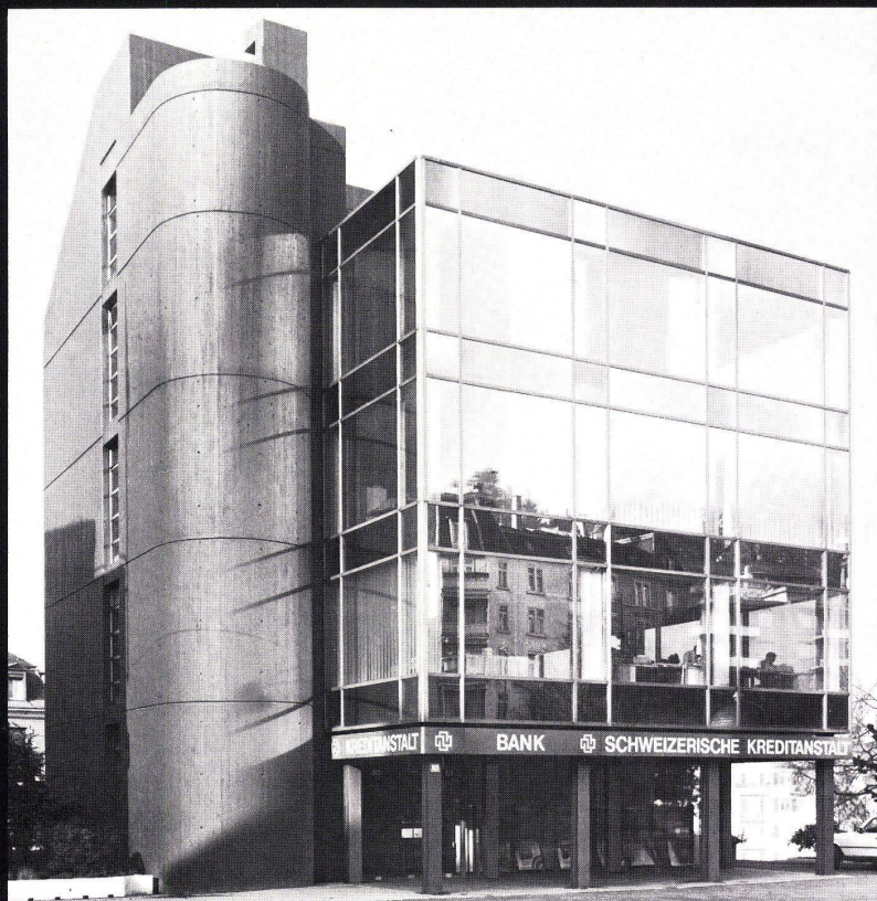
Bankgebäude der Schweizerischen Kreditanstalt am Rigi-platz in Zürich. Aluminium-Fassade mit vollisolierten Fenstern Modell HZ1350.
