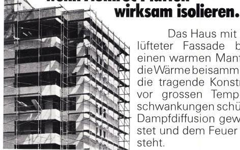
Das Haus mit hinterlüfteter Fassade braucht einen warmen Mantel, der die Wärme beisammenhält. die tragende Konstruktion vor grossen Temperaturschwankungen schützt, die Dampfdiffusion gewährleistet und dem Feuer widersteht.
