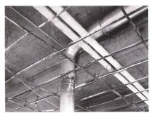
Die Decken-Installationen und die Betondecke sind dank den unbrennbaren PAVAROC-Mineralfaserplatten absolut unversehrt.
