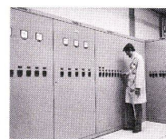
Steuerschranke für Sanitär- und Lüftungsanlagen im Hotel Zürich
