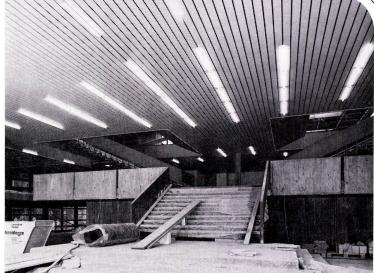
Besser gesagt, weil LUXALON®-Aluminiumdecken die bessere Lösung sind. Als dekorative Akustik- und Lüftungsdecken. Weil sie hohe Korrosionsfestigkeit bieten, weil sie schnell montert werden können, weil sie ideale Gestaltungsmöglichkeiten bieten, weil Leitungen und Installationen immer zugänglich bleiben.
