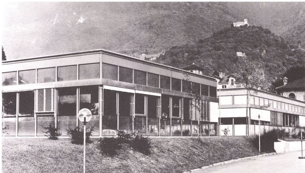
Die Anlage besteht aus zwei Hauptgebäuden mit Einzelbüros und Verbindungsgang. Spannweiten 6,00m × 6,00m und 6,00m × 2,40m. Im Nebengebäude befindet sich eine Werkstatt und Tankanlage, Spannweiten 6,00m × 6,00m und 6,00m × 4,80m.
