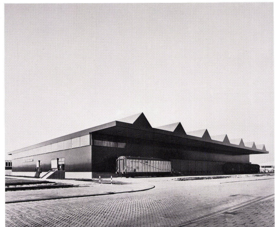
12 Nordwestecke, Eckdetail. Rechts die auskragende Dachkonstruktion, links Vordach. Angle nord-ouest, détail. A droite la toiture en porte-à-faux, à gauche l'avent. Northwest corner, detail. Right, the projecting roof construction, left, canopy.
