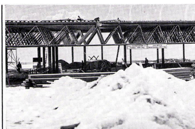
Satellitenstation Leuk: mit Holorib-DLW gebaut.
