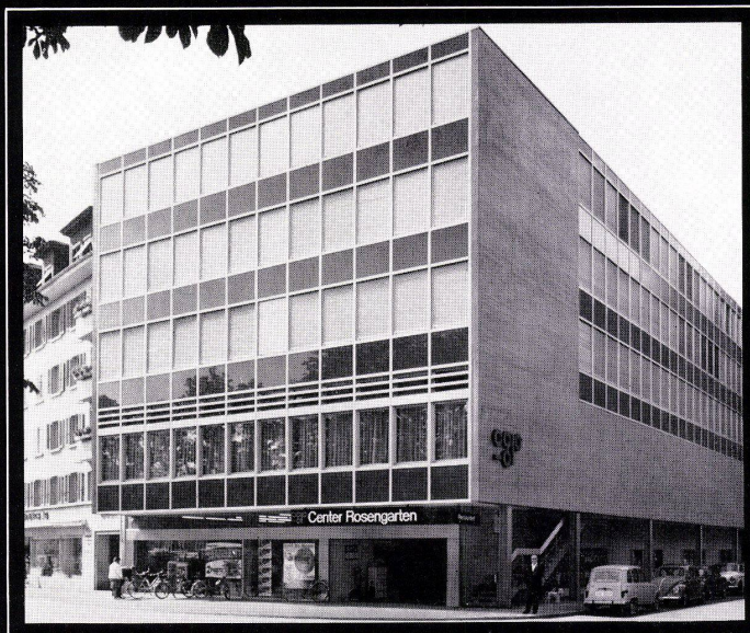
Geschäftshaus-Center Rosengarten, Solothurn. Aluminium-Fassaden mit Modell HZ 750 und vollisolierten ALSEC-50-Fenstern.
