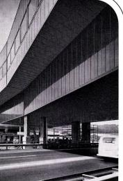
Auch LUXALON®-Fertigwand ist die bessere Lösung: 50 mm starke Paneele aus zwei einbrennlackierten Aluminiumhäuten, die durch Polybrennlackierten Aluminiumhäuten, die durch Polyurethanschaum innig verbunden sind. Keine thermischen Brücken, unsichtbare Befestigungen, hohe Wärmedämmung (0,43 kcal/m²h °C). Gewicht = 8 kg/m². Die 60 cm breiten Standardpaneele,die 20 und 30 cm breiten Ausgleichspaneele und die speziellen Eckpaneele können rasch und mühelos montiert oder demontiert werden.
