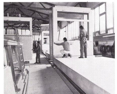
1, 2 Herstellung der Raumzellen in der Fabrik. Fabrication des cellules spatiales en usine. Production of space cells in the factory.
