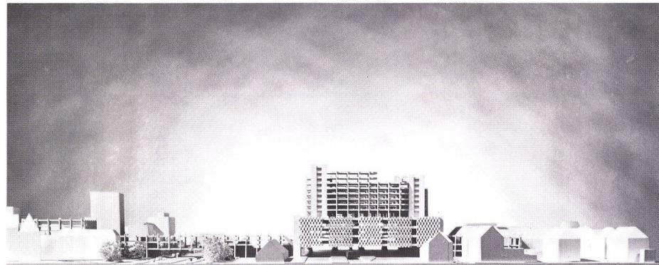
Das Projekt aus dem Jahre 1972 sieht für eine Überbauung des Hauptbahnhofs Freiburg i. B. eine vollständig stützenfreie Überbrückung der Bahngleise vor. Gleiseiseveränderungen können somit jederzeit unabhängig von der Baukonstruktion vorgenommen werden, da die notwendigen Stützen im Bereich der Bahnsteige liegen. Eventuelle spätere Erweiterungen sind nach allen Richtungen hin möglich.
