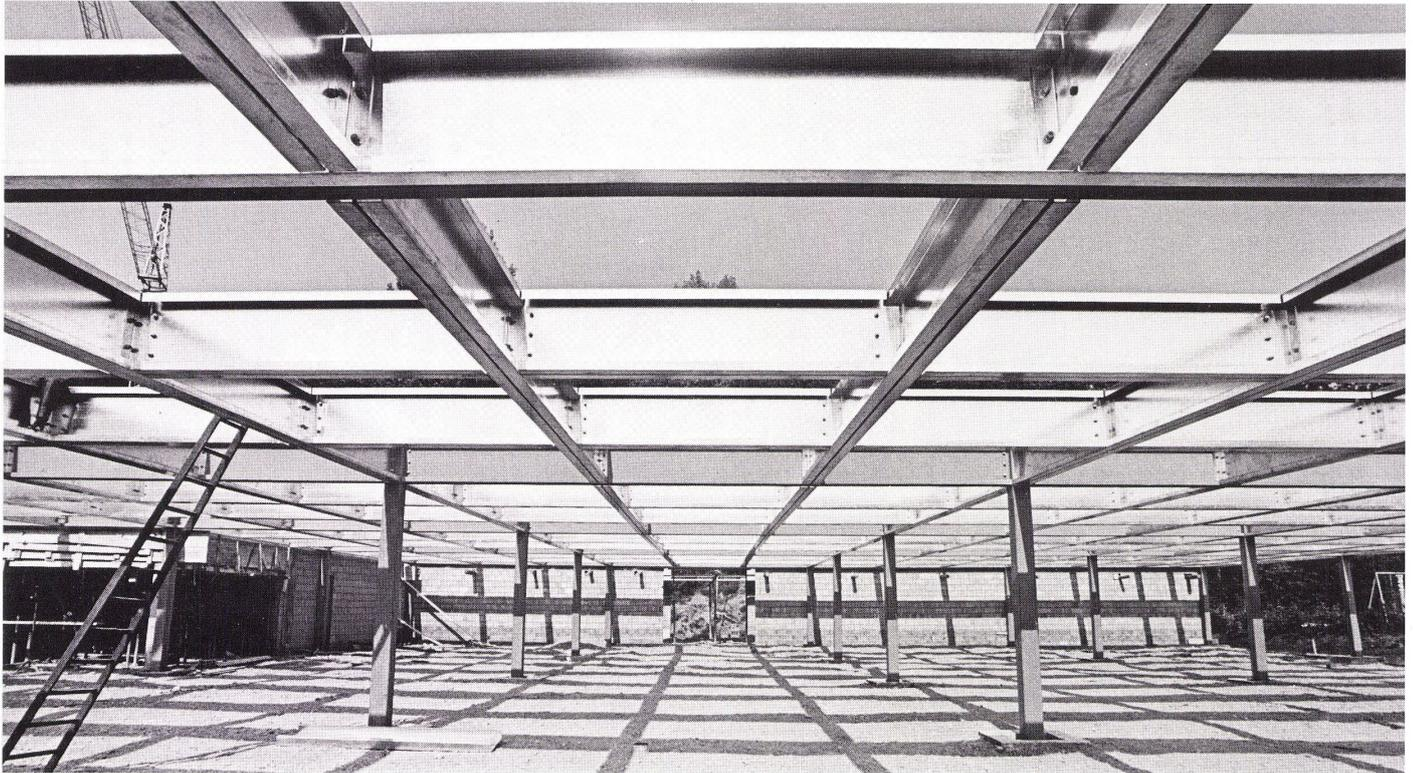
RHS-Stützen 200/200 mm und C-Profilträger abgekantet aus 2,5-, 3- oder 4-mm-Stahlblech als Deckenstruktur zu quadratischen Elementen von 7200/7200 mm verschraubt. Planungsrastrer 1200/1200 mm.
