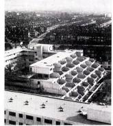
Ein Großprojekt von fast 1000 Wohnungen auf einem 10 ha großen Gelände in Südlondon, das von der Firma John Laing Construction Ltd., London, nach dem «12-M-Jesperson»-System erstellt wurde. (BFF)
