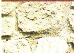
unregelmässigem Bruchsteinmauerwerk
