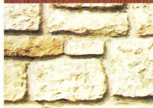
regelmässigem Bruchsteinmauerwerk
