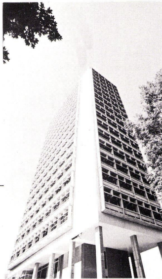
Raff-Lamellenstoren am Neubau der PTT in Ostermündigen
