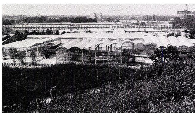
1 Teilaussicht der Tribüne. Auf einer Stahlrohrkonstruktion sind die Holzaufbauten verankert. Hoch oben die Regie- und Fernsehkanzel.
