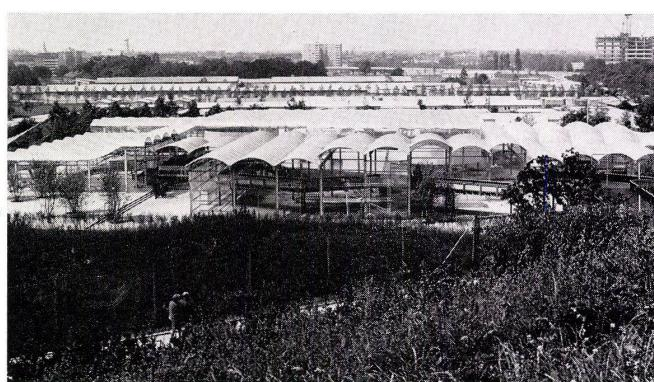
1 Teilansicht der Tribüne. Auf einer Stahlrohrkonstruktion sind die Holzaufbauten verankert. Hoch oben die Regie- und Fernsehkanzel.
