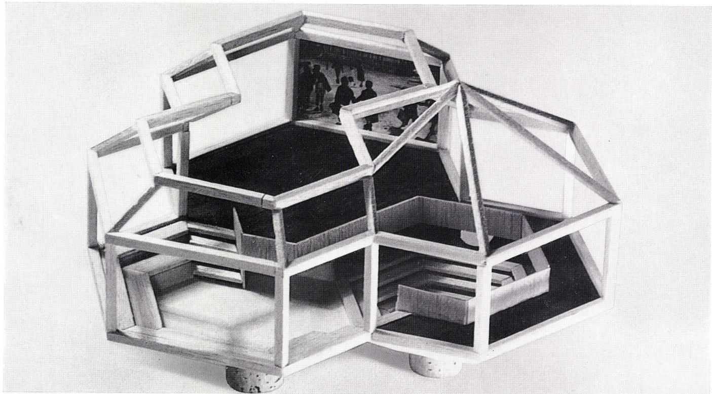
Die hier im Entwurfsstadium gezeigte Schule besteht aus der Addition zweier Polyeder, deren Grundfläche sechseckig ist. Die Schule ist zur Zeit noch im Bau und wird auf Beginn des kommenden Schuljahres hin fertiggestellt sein. Die Tragstruktur wurde aus verleimten Holzbalken erstellt, die Dach- und Fassadenflächen bestehen aus farbig beschichteten Sandwich-Platten.
