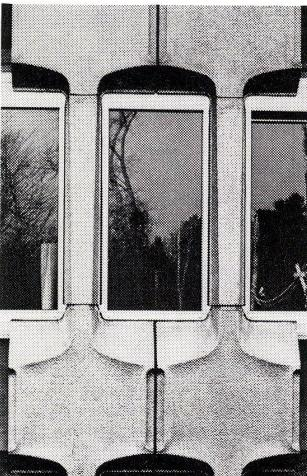
Eine Modellaufnahme des neuen BMW-Verwaltungsgebäudes in München. Das Hochhaus verfügt über achtzehn durch vier zentrale Hängesäulen getragene Geschosse. Die Vollklimatisierung ermöglicht eine Festverglasung im Alcast-Element. Die dahinterliegenden Großraumbüros erfordern aus akustischen Gründen eine Schräglagestellung der Fenster. Beide Funktionen bestimmten die Form der Elemente. Die Montage der Alcast-Elemente begann vor wenigen Wochen.
