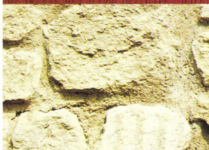
unregelmässigem Bruchsteinmauerwerk
