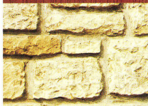
regelmässigem Bruchsteinmauerwerk
