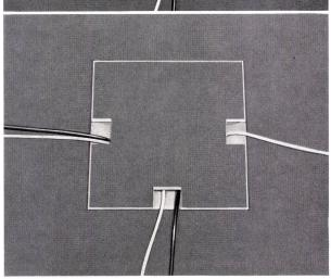
dazu passender Boden-Verbindungskanal: 3zügig, 200 mm breit, 30 mm hoch Pat. ang.
