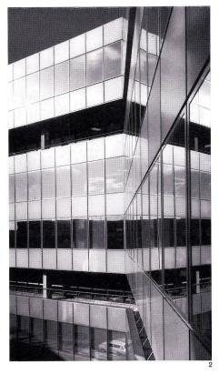
Notwendigkeit zur Gliederung des Bauwerks: Sie folgt aus der Größe der Baumasse; aus der Kombination von Hochhaus und Flachbau; aus den geforderten Bauabschnitten; aus der Forderung nach unabhängiger Vermietung von Bauteilen; aus dem Wunsch nach Anpassung an den baulichen Maßstab der Umgebung; aus der erwünschten Bildung von geformten Freiräumen zwischen Gebäude und Umgebung.
