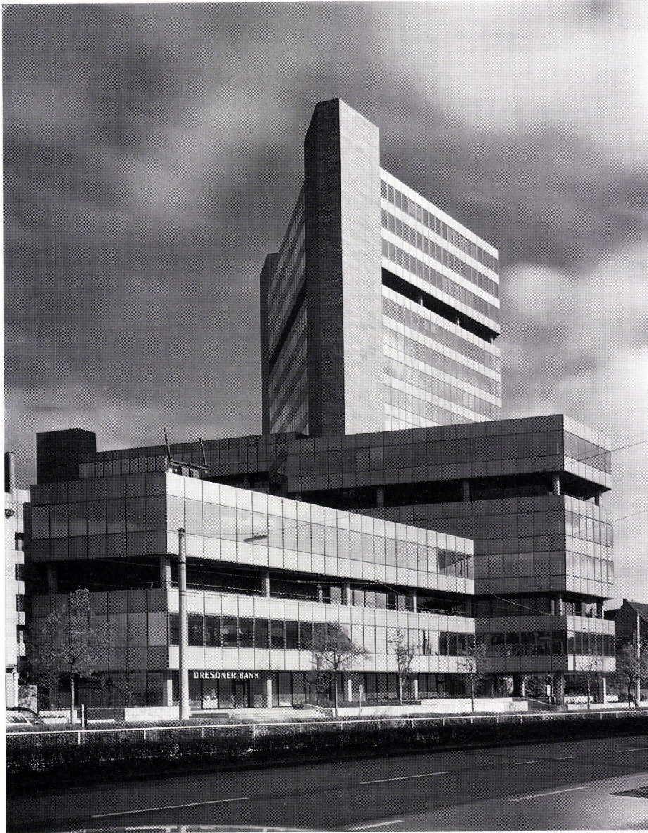
1 Ansicht von der Aachener Straße. Vue de la Aachener Straße. View from Aachener Straße.
