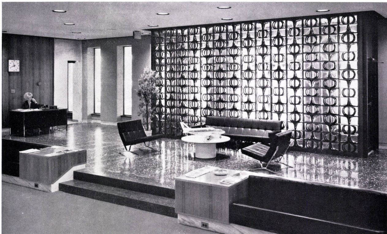
Glasbausteinwand aus Reliefsteinen CHIARO I und CHIARO II. Die CHIARO-Steine wurden für PCC von der bekannten Design-Firma Peter Muller-Munk Associates entworfen und weisen beidseitig ein stark erhobenes, von schwarzem, abriebfestem Email betontes Relief auf.
