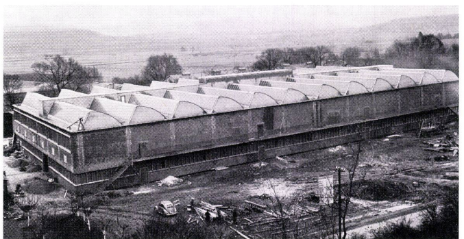
4 Klimaträger im Bau. Zuluftkanal für Druckereisaal.
