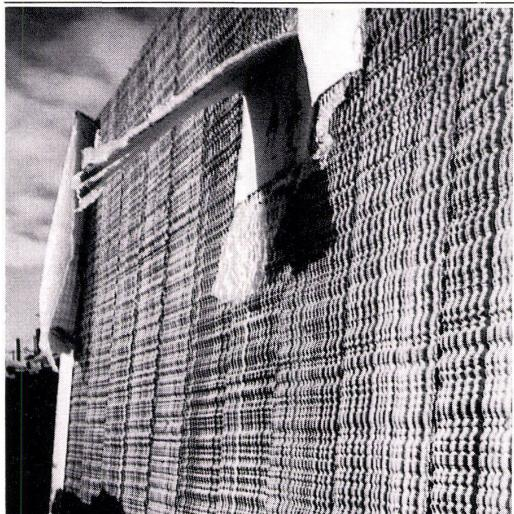
Neuartige Wegwerfschalungs-Matrizen strukturieren Sichtbeton im Hochbau:
