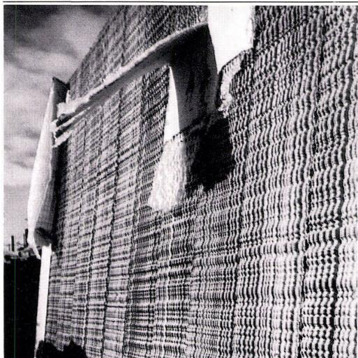
Neuartige Wegwerfschalungs-Matrizen strukturieren Sichtbeton im Hochbau:
